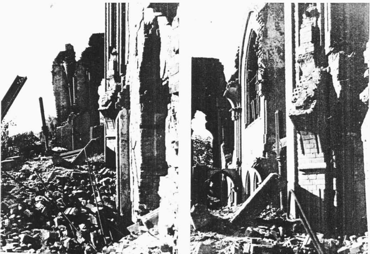
Trümmer der Reformationskirche, Alfredstraße 83, nach den Bombenangriffen 1943/44
