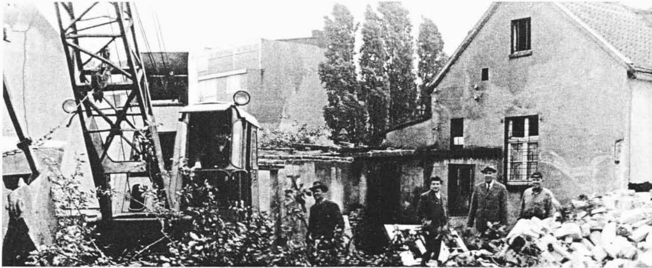
Pfr. Reitz (2. von rechts) war froh, als endlich die Abbrucharbeiten begannen.
