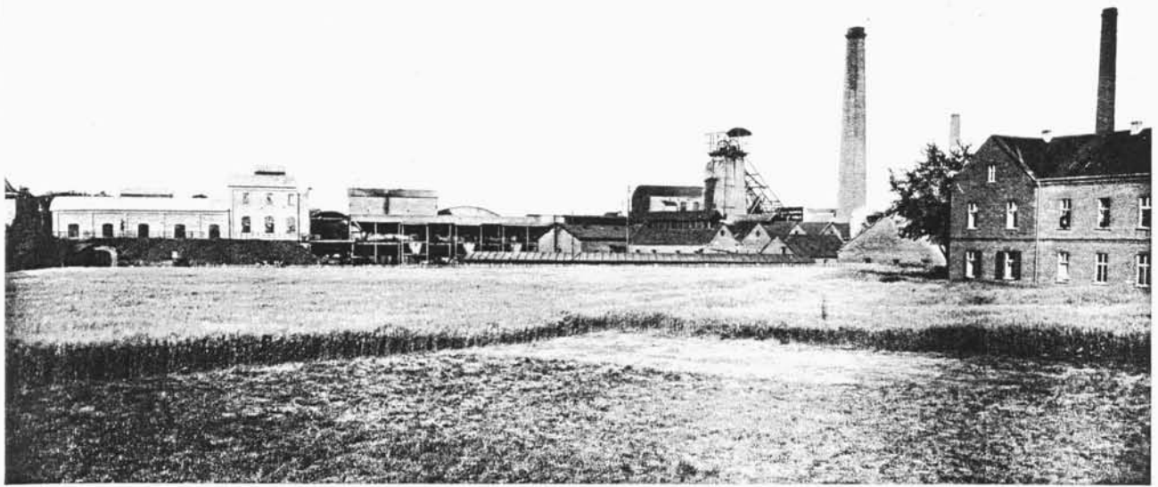
Schachtanlage 1 in ESSEN - Rüttenscheid (Aufnahme um die Jahrhundertwende). Als Versuchsabhausen 1860 in Betrieb genommen und nach Erweiterung und Ausbau Förderschacht bis 1911. Anschließend Wetterschacht bis 1966.
