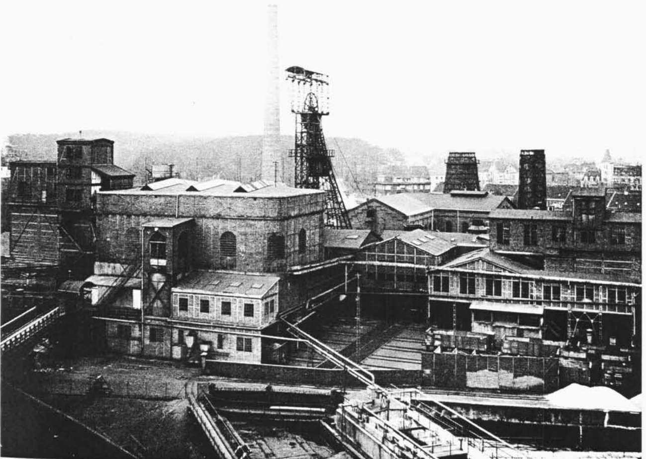
Schachtanlage 1/3 in ESSEN - Rüttenscheid. Beginn des Abteufens des Schachtes 3 1903. Inbetriebnahme 1905. Diente nach Stilllegung der Anlage 1949-1966 der Wetterführung und der Wasserhaltung. 1951 wurde mit dem Abbruch begonnen.
